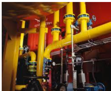
Figura 16. Tuberías en la cámara de máquinas de un barco (Fuente: Google imágenes)
